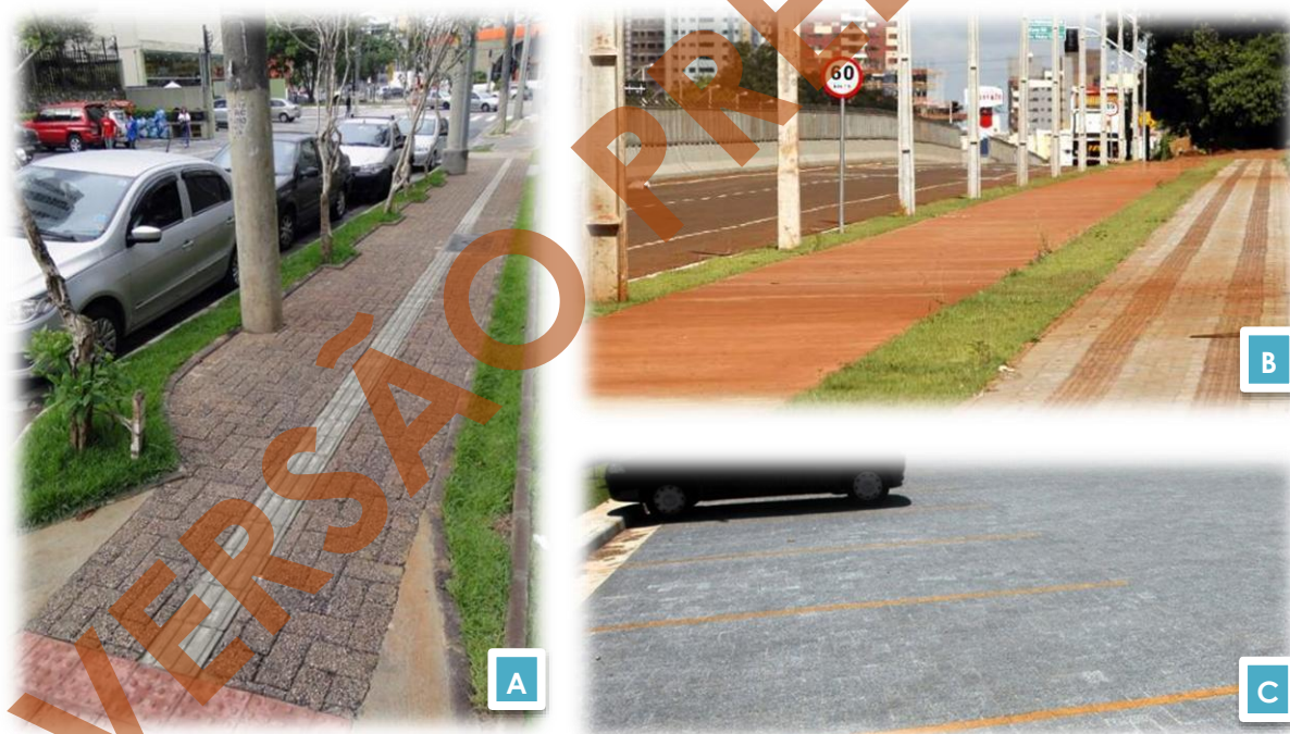
Figura 119 – (A) Exemplo de aplicação de piso drenante em calçada, (B) Calçada ecológica do município de Maringá/PR e (C) Exemplo de aplicação de piso drenante em estacionamentos.
