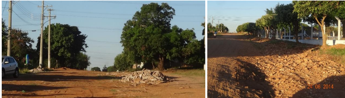
Figura 79 – Vias não pavimentadas com utilização de resíduos da construção civil como cascalhamento no município de Alcinópolis/MS.
