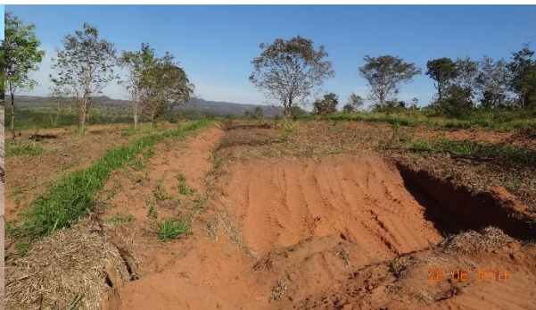
Figura 138 - Implantação das curvas de nível e barraginha no Assentamento Santa Fé – Alcinópolis/MS
