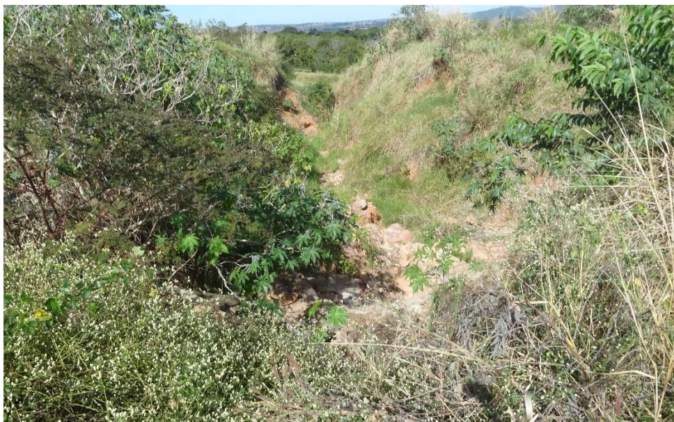
Figura 112 – Local do dispositivo de lançamento de águas pluviais localizado próximo a BR 359 em Alcinópolis/MS
