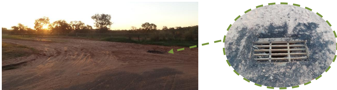
Figura 110 – Possível poço de visita com grelha no município de Alcinópolis/MS.
