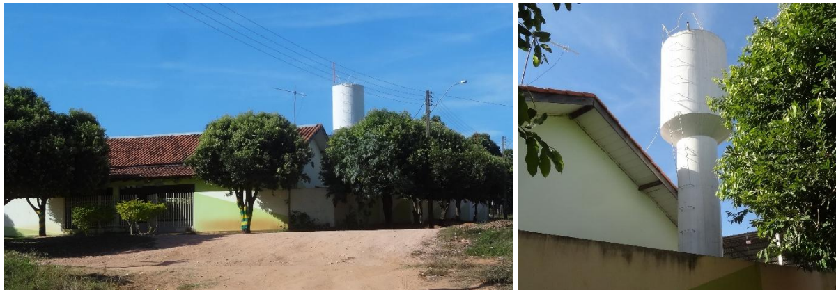
Figura 123 – Reservatório do abastecimento de água do Distrito Novo Belo Horizonte – Alcinópolis/MS.
