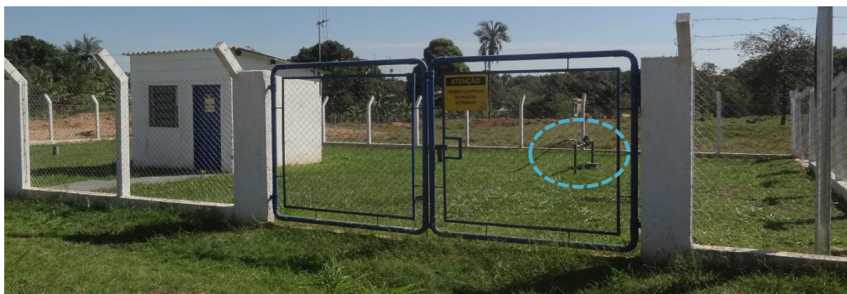
Figura 34 – Aspectos construtivos da localização do poço tubular profundo ALC-002 em Alcinópolis/MS.
