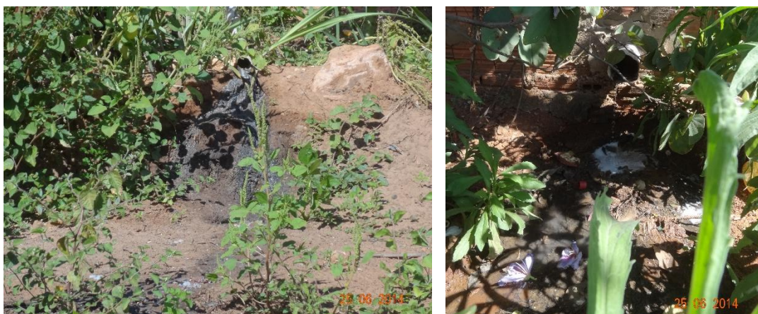
Figura 50 – Dispositivos que indicam a possível lançamento de águas cinzas nas vias públicas
