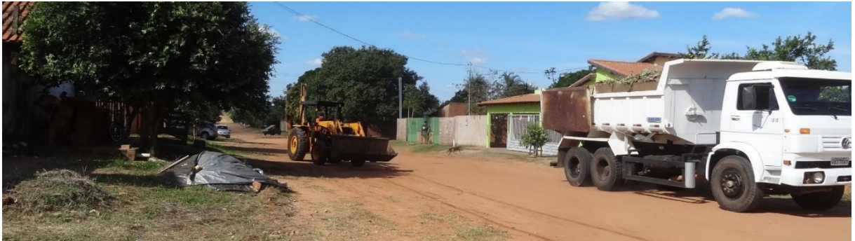
Figura 71 – Pá carregadeira e caminhão basculante utilizados para a remoção de resíduos de podas e roçada das vias públicas de Alcinópolis/MS.
