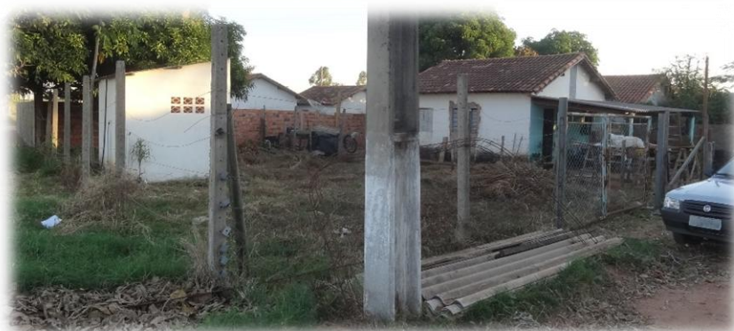
Figura 40 – Aspectos construtivos da localização do poço tubular profundo ALC-004 em Alcinópolis/MS.
