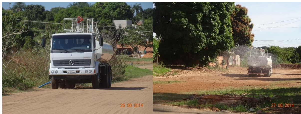
Figura 29 – Captação de água superficial do Ribeirão do Retiro para umidificação das vias não pavimentadas do município de Alcinópolis/MS.
