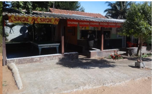
Figura 136 – Exemplo de local que utiliza muretas para impedir a entrada de águas pluviais.
