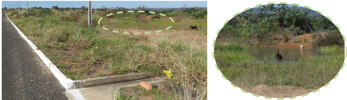
Figura 118 – Sistema de drenagem da Rodovia BR 359 e retenção em barraginha no município de Alcinópolis/MS.
