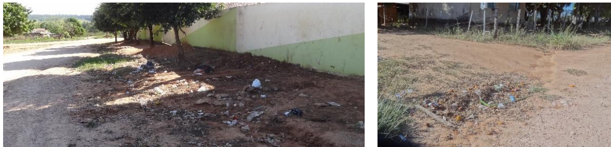
Figura 130 – Resíduos dispersos no solo, rejeitos e verdes no Distrito Novo Belo Horizonte – Alcinópolis/MS.
