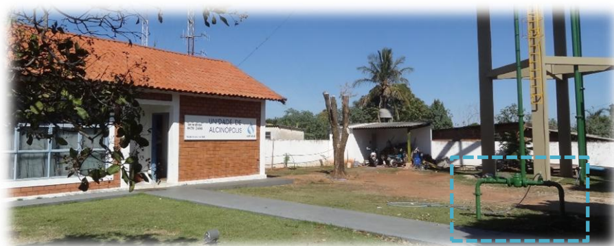
Figura 37 – Aspectos construtivos da localização do poço tubular profundo ALC-003 em Alcinópolis/MS.
