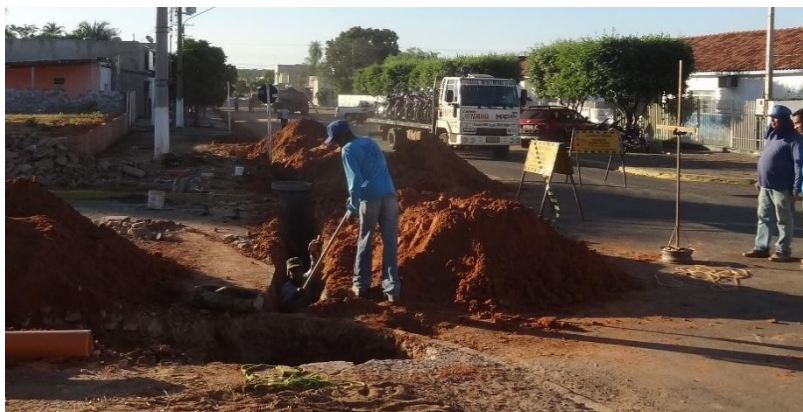
Figura 52 – Implantação da rede coletora de esgoto sanitário em Alcinoópolis/MS.
