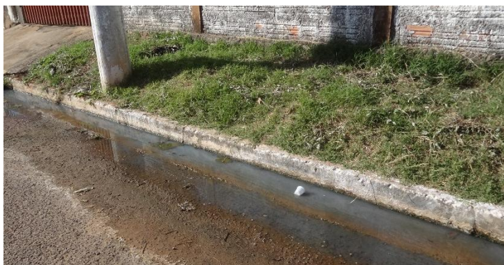
Figura 106 – Provável lançamento de águas cinzas nas sarjetas que podem ser destinadas à boca de lobo no município de Alcinópolis/MS.
