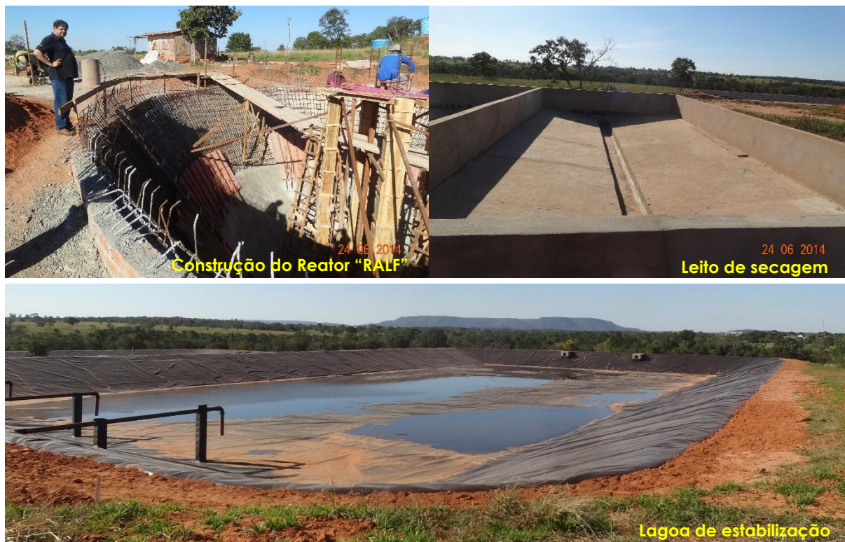
Figura 54 – Estruturas da ETE em construção no município de Alcinoópolis/MS.
