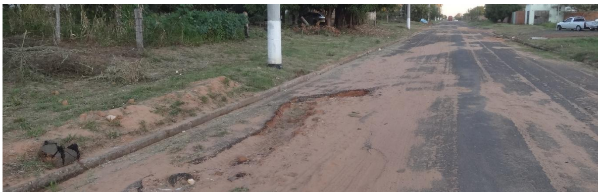
Figura 99 – Pavimento com defeito na Rua Sebastião Filisbino Furtado com sarjetas intactas no município de Alcinópolis/MS.
