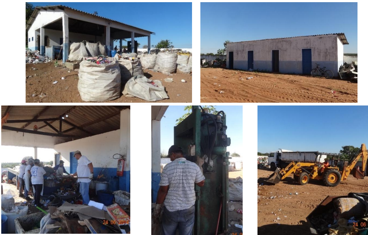
Figura 64 – Estrutura existente da Unidade de Triagem de Resíduos (UTR) da COOPERCAL no município de Alcinópolis/MS
