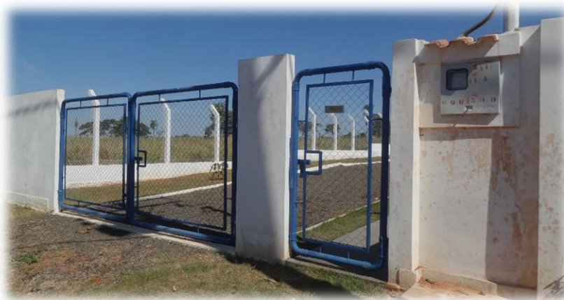
Figura 42 – Aspectos construtivos da localização do poço tubular profundo ALC-005 em Alcinópolis/MS.
