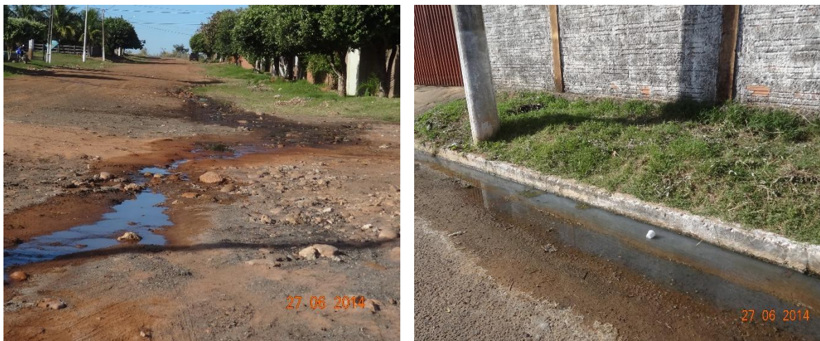
Figura 49 – Lançamento de águas cinzas em vias públicas em Alcinópolis/MS
