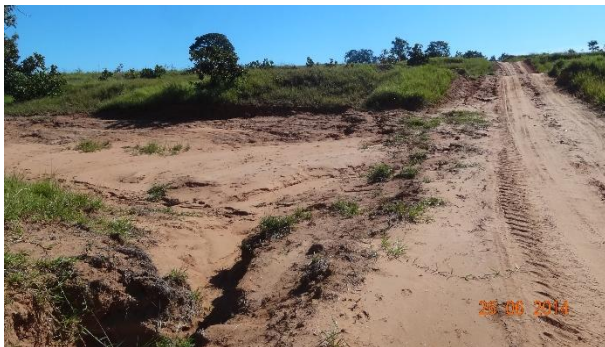
Figura 137 – Via de acesso e vala de escoamento de águas pluviais no Assentamento Santa Fé – Alcinópolis/MS
