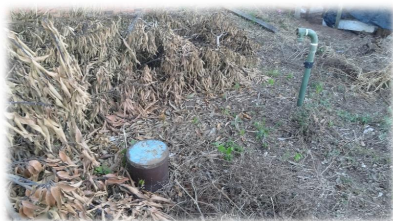
Figura 41 – Detalhes do Poço tubular profundo ALC-004.
