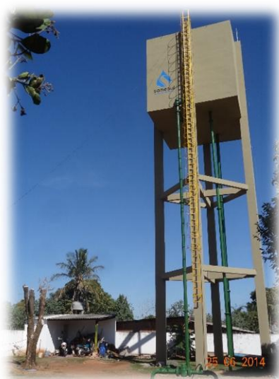
Figura 46 - Reservatório Elevado REL-001 do SAA.
