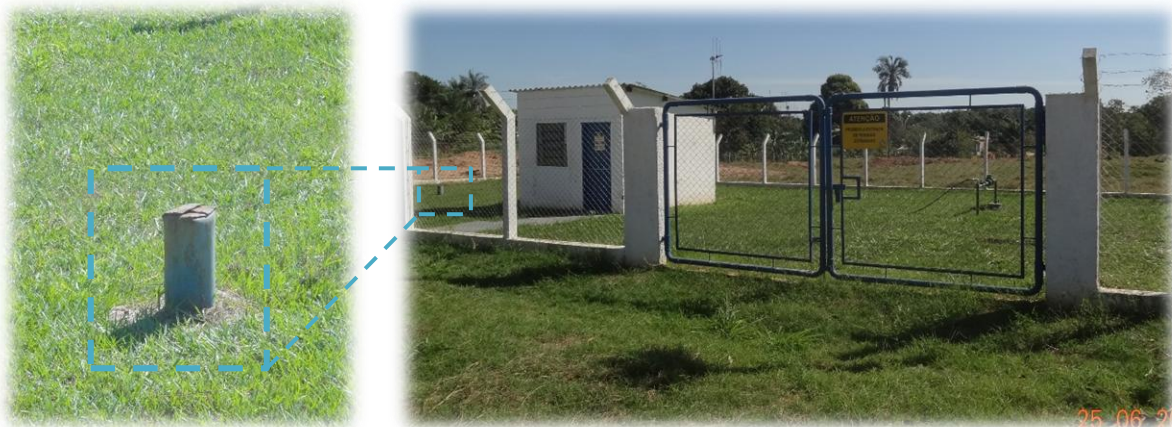
Figura 32 – Aspectos construtivos da localização do poço tubular profundo ALC-001 em Alcinópolis/MS. Fonte: Deméter Engenharia Ltda., 25/06/2014.
