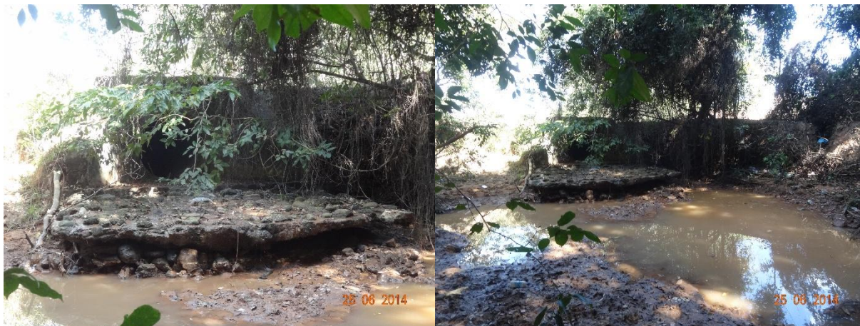
Figura 116 – Dispositivo de lançamento de águas pluviais no Ribeirão do Retido no município de Alcinópolis/MS.
