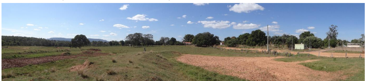
Figura 115 – Sistema de contenção de águas pluviais no município de Alcinópolis/MS.
